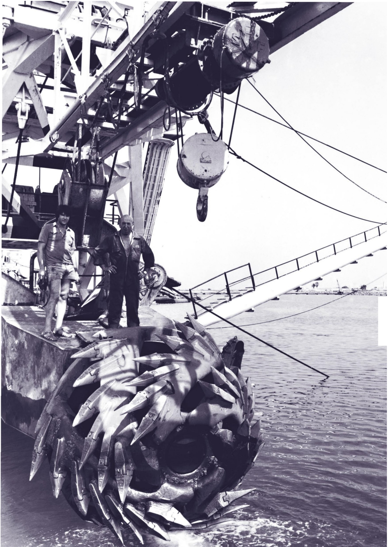
Lavori di dragaggio per la realizzazione del porto industriale di Cagliari
